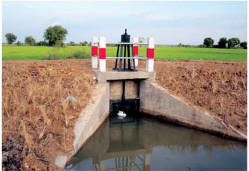
ទិដ្ឋភាពសំណង់លូស្នាក់ទឹក ដែលបានសាងសង់រួច
