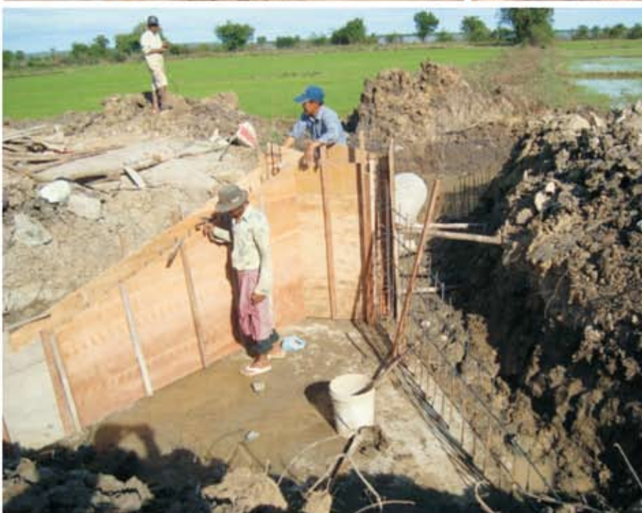
សកម្មភាពរៀបចំការតុម្ក ស្នាបសំណង់លូស្នាក់ទឹក លើទំនប់រងជ្រោយចេក
