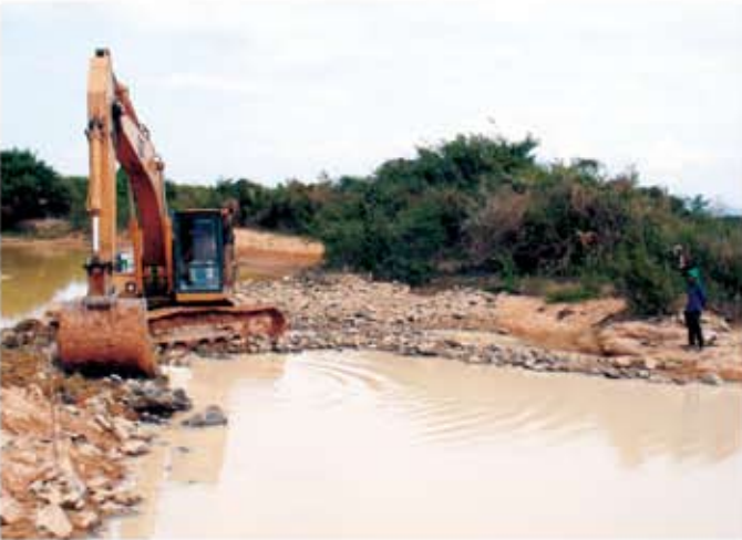
សកម្មភាពត្រៀមចក្រកំពុងកាយដីស្មារទំនប់អាងទឹក ២០ ឧសភា
